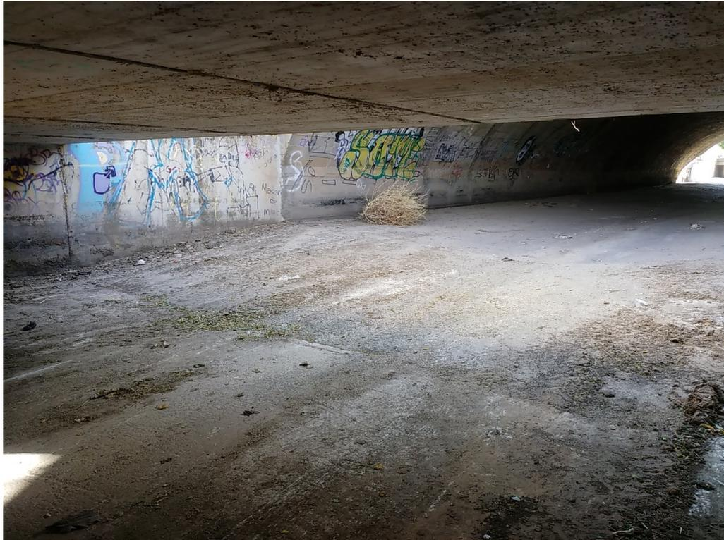
Figura 9. Fotografía de la situación actual del canal bajo el Puente 14, que muestra la diferencia de ancho entre ambos puentes, y el desnivel a modo de rampa entre la salida del Puente 13 y la entrada al Puente 14.
