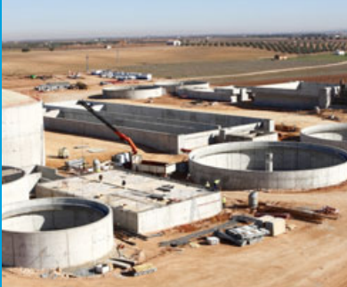
Nueva Depuradora de Agua Residual (EDAR)
