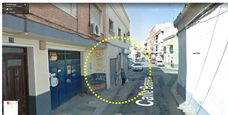
Figura 83. Calle Bataneros. Aceras con dimensiones muy reducidas, provocan que los peatones necesiten usar el lecho carrozable, principalmente cuando son dos o más.
