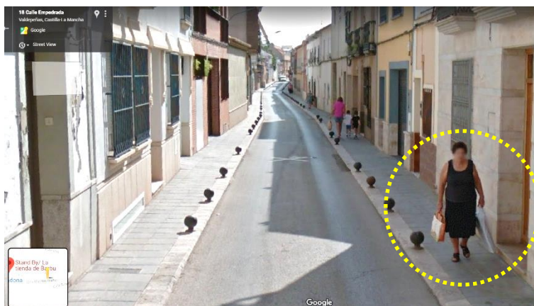
Figura 81. Calle Empedrada. Pavimentación de aceras y bolardos para restringir parada de vehículos. Los bolardos también delimitan las bandas peatonales que tienen un ancho insuficiente. El lecho carrozable asfaltado y las aceras ligeramente elevadas no invitan al funcionamiento como plataforma única.
