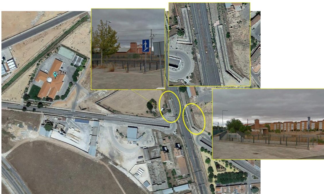
Figura 134. Detalle paso subterráneo acceso a AFAD
