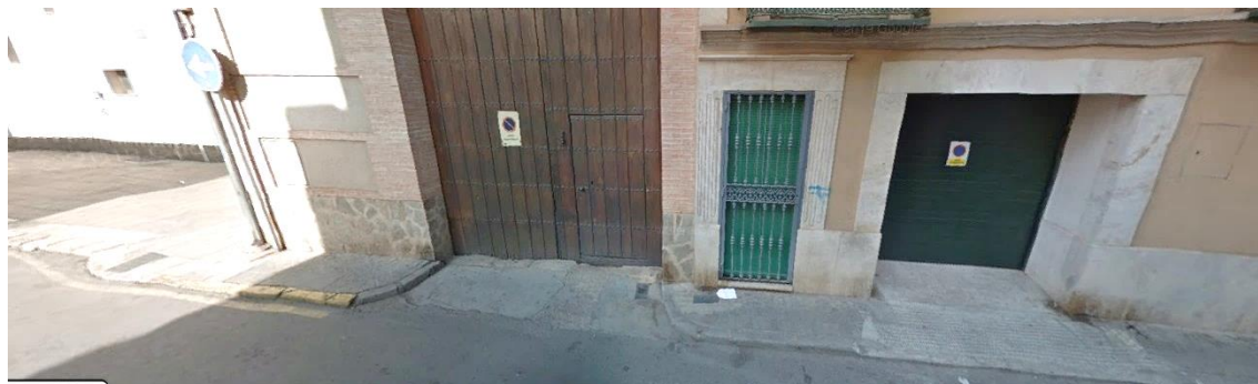
Figura 90. Ejemplo discontinuidad longitudinal de las aceras y entradas a garajes
