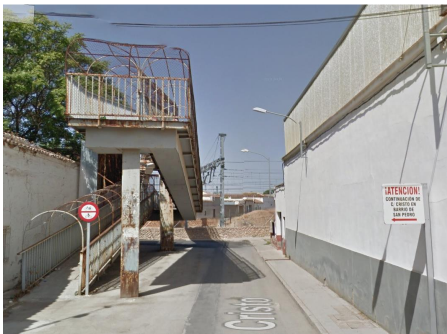
Figura 41. Pasarela que conecta el casco urbano con el Barrio de San Pedro
