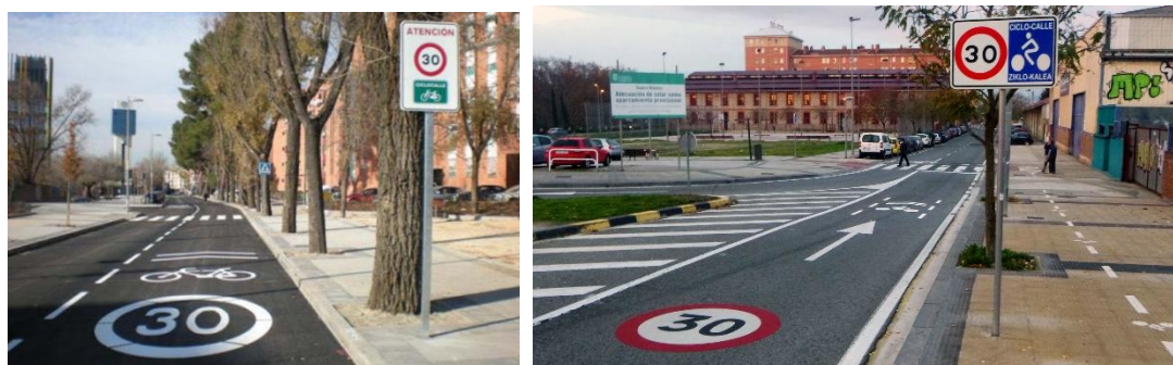
Figura 34. Ciclocalles: ejemplos de señalización vertical y horizontal
