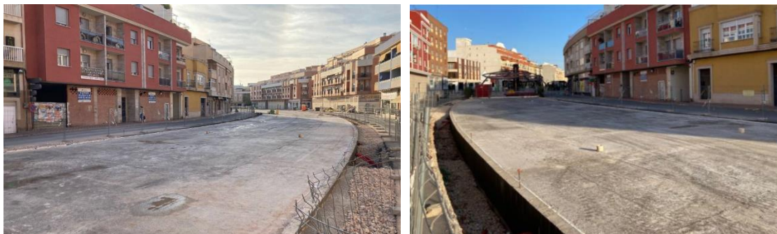
Figura 45. Imagen del estado de las obras de cubrimiento del Canal. Noviembre 2020
