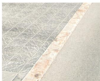
ACERADO CON ADOQUÍN DECORATIVO PIEDRA CALIZA imitación pizarra antideslizante 40x40
