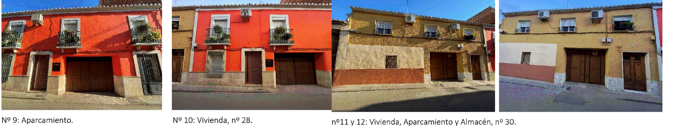
Nº 9: Aparcamiento. Nº10: Vivienda, nº 28. Nº11 y 12: Vivienda, Aparcamiento y Almacén, nº 30.
