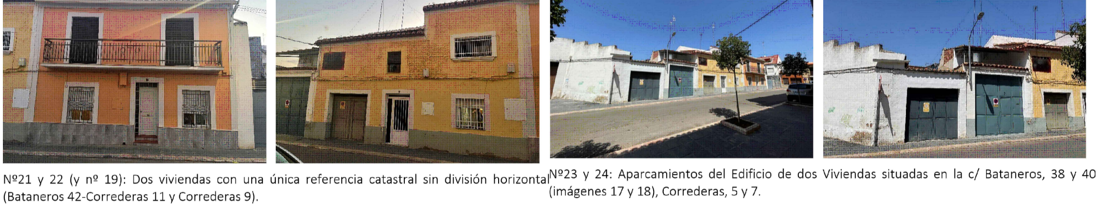
Nº21 y 22 (y nº 19): Dos viviendas con una única referencia catastral sin división horizontal. Nº23 y 24: Aparcamientos del Edificio de dos Viviendas situadas en la c/ Bataneros, 38 y 40 (Bataneros 42-Correderas 11 y Correderas 9). (imágenes 17 y 18), Correderas, 5 y 7.
