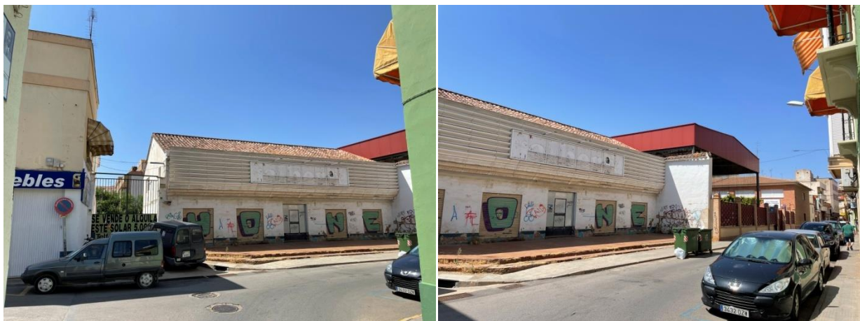
Nº3 y 4: Nave comercial con LMO de demolición.
