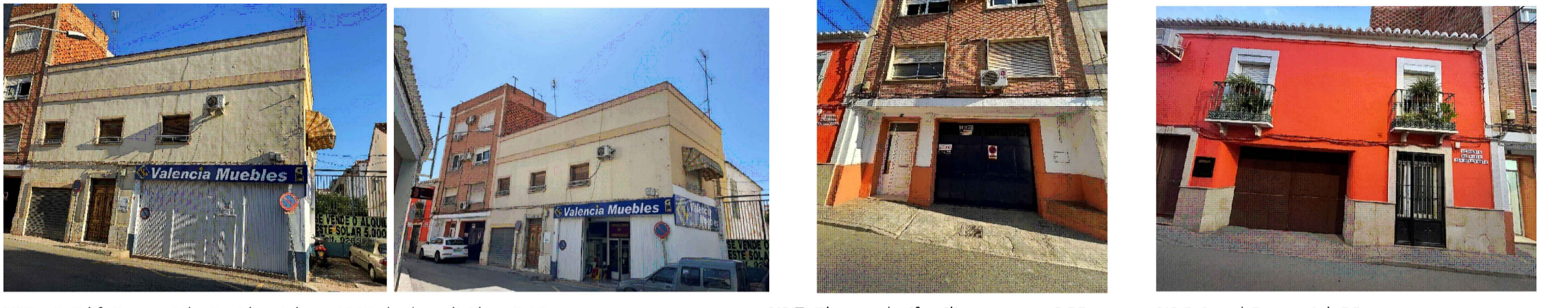
Nº5 y 6: Edif. Comercial y Residencial con LMO de demolición, nº 18. Nº7: Bloque plurifamiliar en uso, nº 20. Nº8: Local Comercial, 26.
