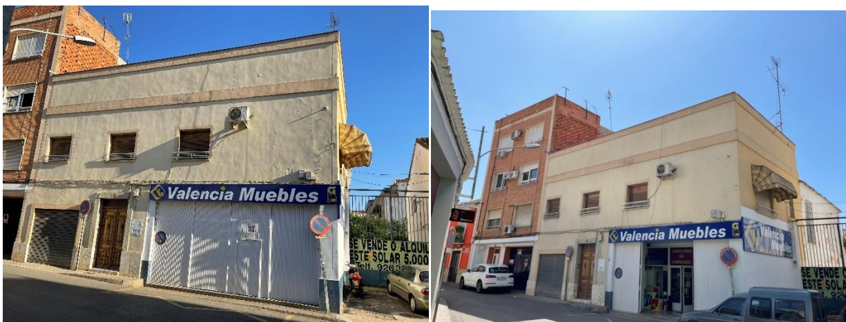
Nº5 y 6: Edif. Comercial y Residencial con LMO de demolición, nº 18.
