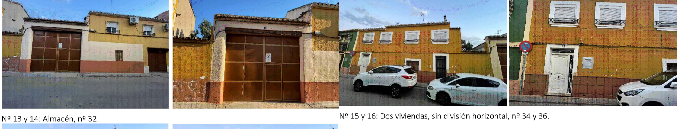
Nº 13 y 14: Almacén, nº 32. Nº15 y 16: Dos viviendas, sin división horizontal, nº 34 y 36.
