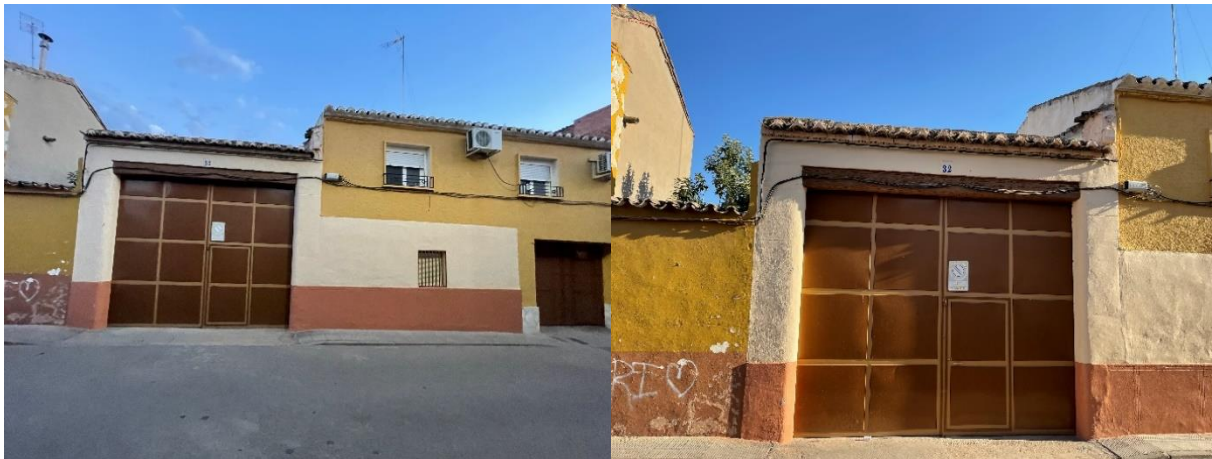
Nº 13 y 14: Almacén, nº 32.
