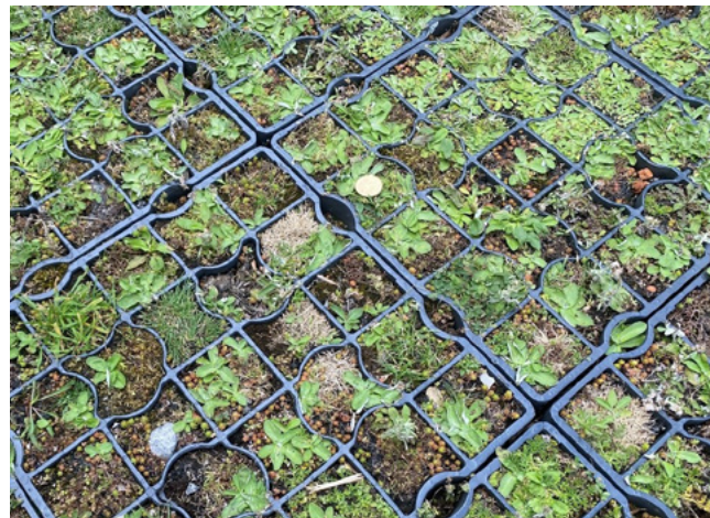
Figura 4. Detalle de celdas rellenas de suelo donde se evapora el agua y crece la hierba, además de proteger a los viandantes del barro.
