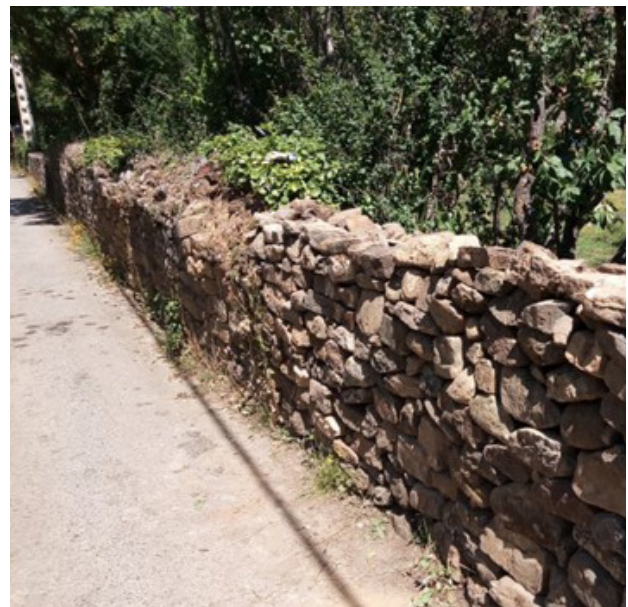
Figura 35. Muro de piedra seca. Fuente: proyecto Steps for LIFE .
