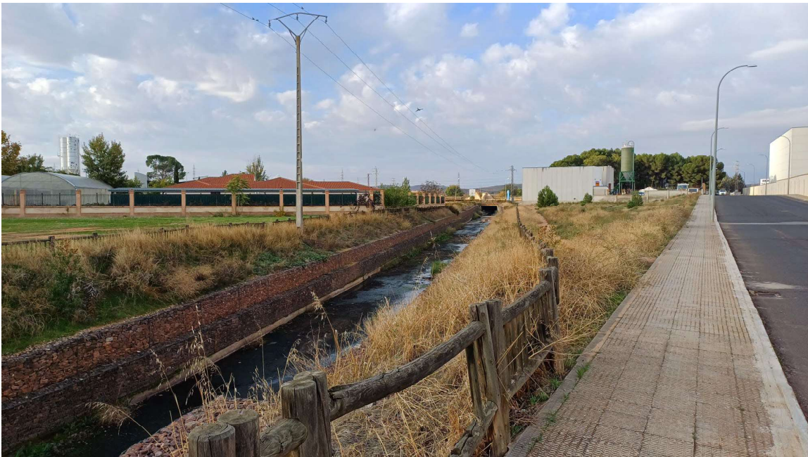
Imagen de cauce abierto de la cañada Romero y de la zona de renaturalización
