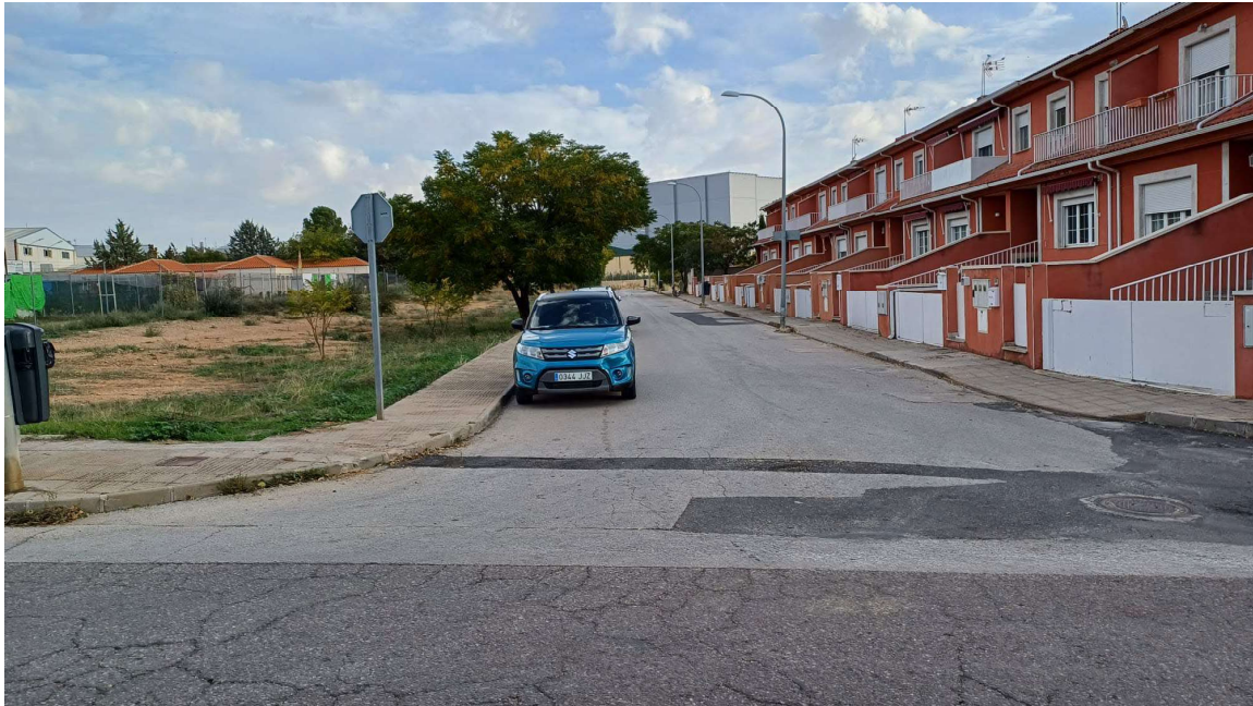
Imagen del tramo a ejecutar del sistema general 5 y 6 en la calle Rafael Llamazares
