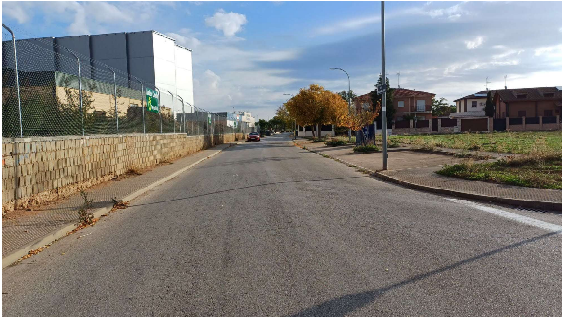
Imagen del tramo a ejecutar del sistema general 5 y 6 en la calle Rafael Llamazares
