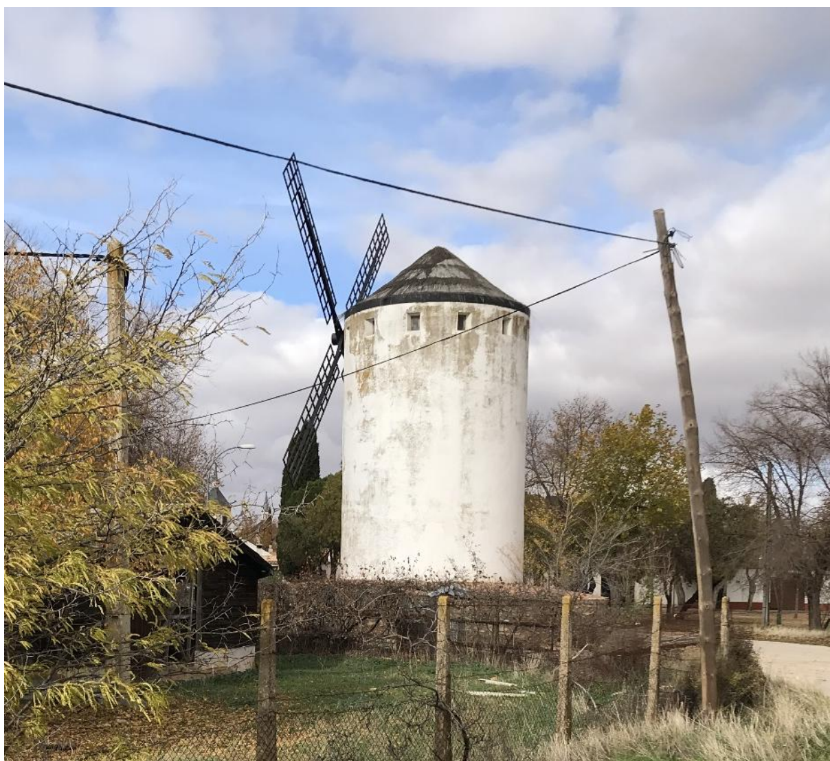
Depósito de almacenamiento de aguas en forma de molino tradicional
