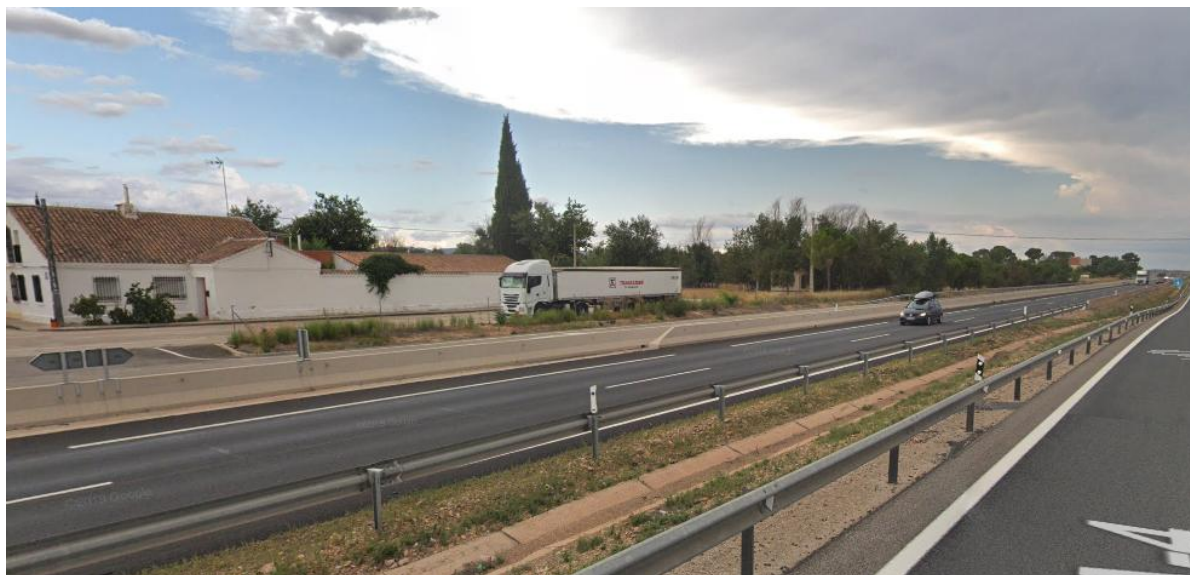
Autovía A-4. Al fondo la Vía de Servicio, el núcleo de Consolación y el Sector 40.
