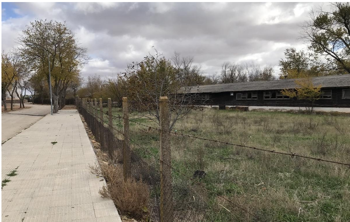
Vial de conexión con Sector 40. Vallado perimetral y barracón
