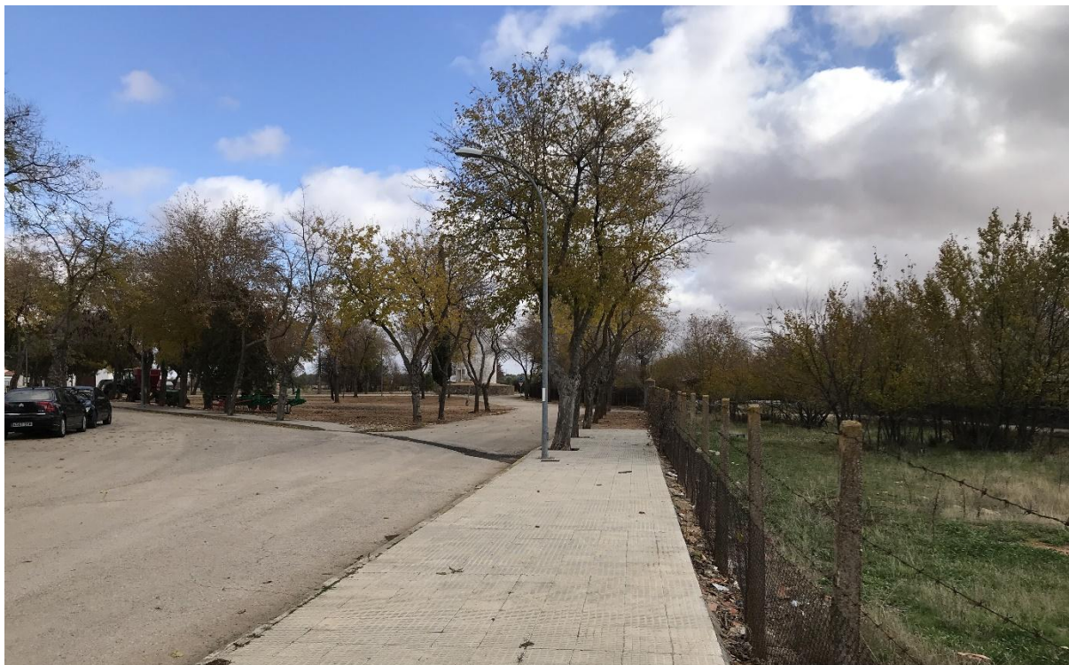
Vía C/ Travesía Tres. Final del vial, hacia CR-5214.
