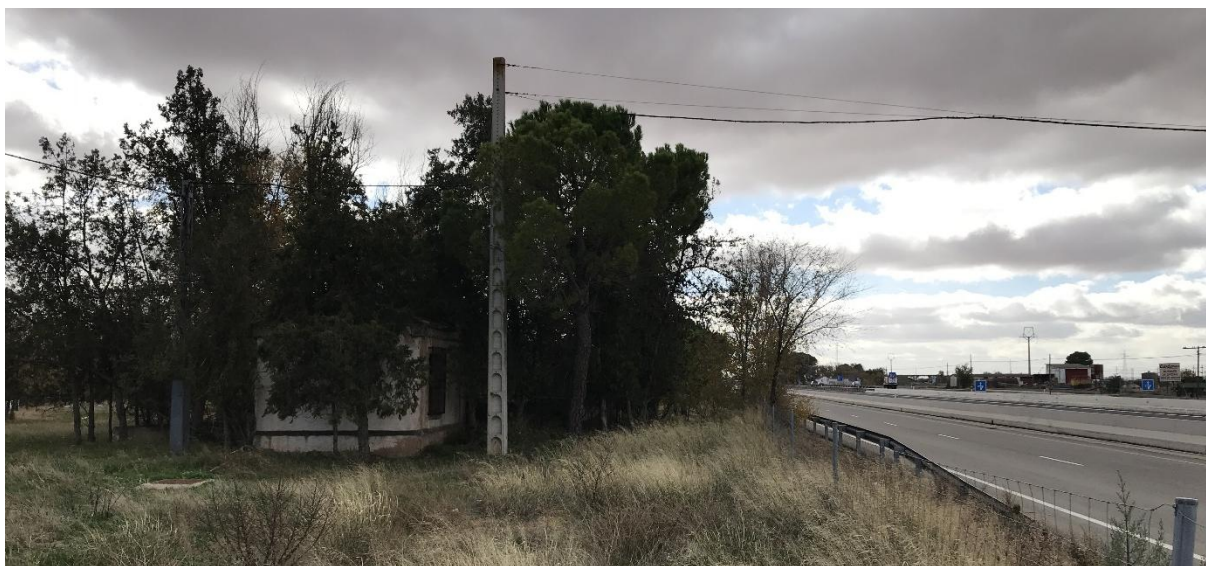
Instalaciones de Saneamiento en el núcleo de Consolación.
