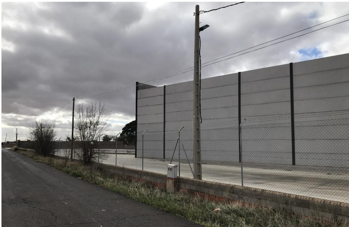
Nueva nave construida en Sector 40 'Consolación Sur' y Carretera CRP-5214
