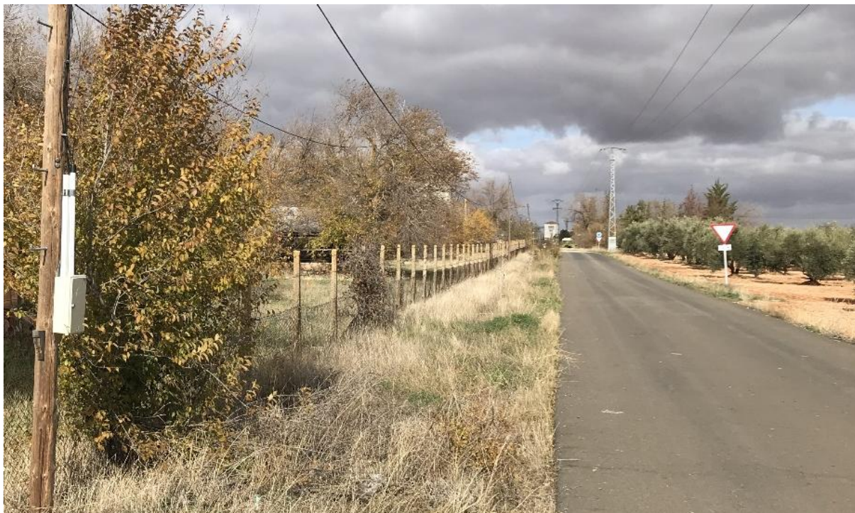
CR-5214. Margen izquierda Sector 40 "Consolación Sur". Línea teléfono y vallado perimetral.
