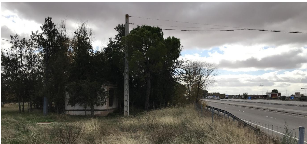
Estación Depuradora de Aguas Residuales Consolación.
